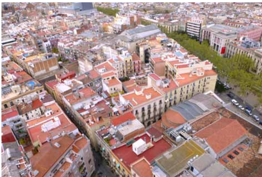
APROFITAR ELS TREBALLS DE REHABILITACIÓ DE COBERTES I FAÇANES, PER INCORPORAR MILLORES ENERGÈTIQUES, ES UNA MESURA QUE PERMET REDUIR LA INVERSIÓ I FACILITA L'AMORTITZACIÓ AMB UN TERMINI MOLT MÉS CURT
