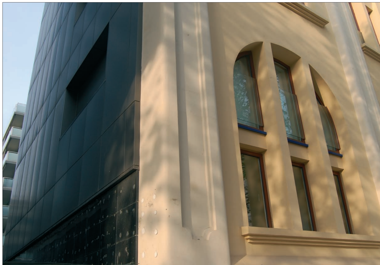
En la rehabilitació de l'edifici superior la façana lateral ha estat aïllada i s'ha acabat amb materials nous
